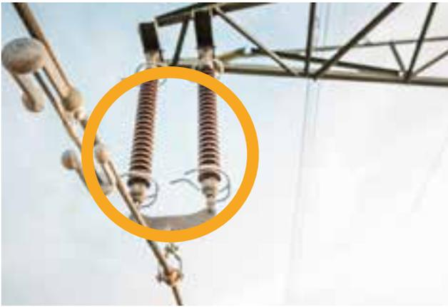
Strom aus der Leitung darf nie in den Strommast und dadurch in die Erde gelangen. Das verhindert ein Isolator.
