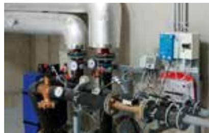
In einer Wärmeübergabestation wird die Wärme des Wassers an das Heizsystem des Hauses übergeben.
